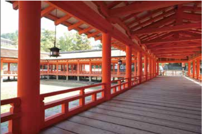
上／宮島全体が神と考えられていたため、「ご神体」を傷つけないよう潮の満ち引きのある場所に厳島神社が造られたといわれる 下／廻廊の床板は1間に8枚で、釘は使われていない
