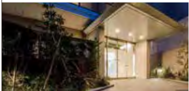
「Brillia 志木 Place」 建物竣工写真 (2022年3月撮影) (※)
