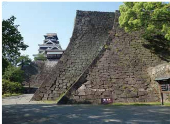
上/右側が加藤清正時代の「武者返し」の石垣、左側は急な角度が出せる算木積み工法が開発された後の細川時代の石垣
